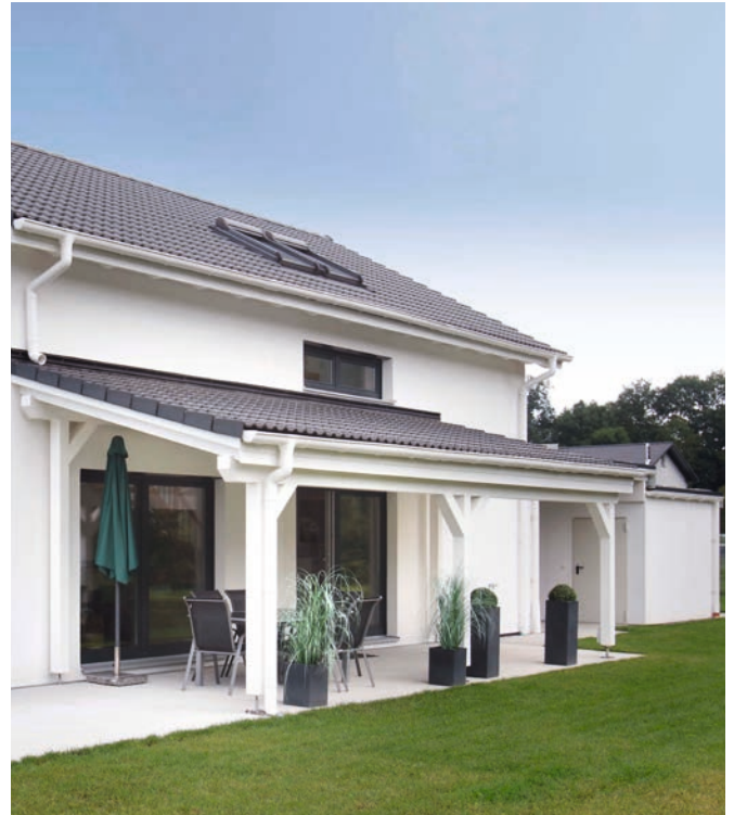
Solides Dach über der Terrasse
