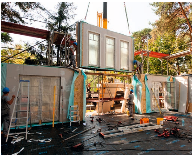
...und das Erdgeschoss auf das Fundament montiert. Anschließend wird das Obergeschoss aufgesetzt.
