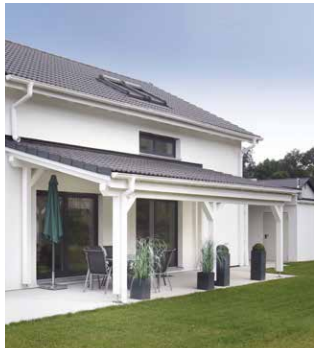
Solides Dach über der Terrasse
